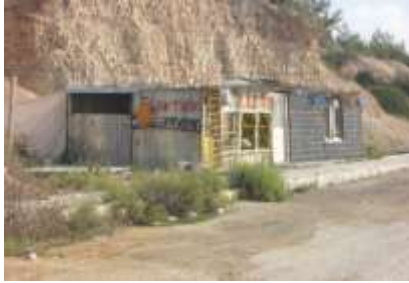
Şekil 16. Kargakekeç Toplu Konut Alanı Elektrik Tamirat Dükkanı
