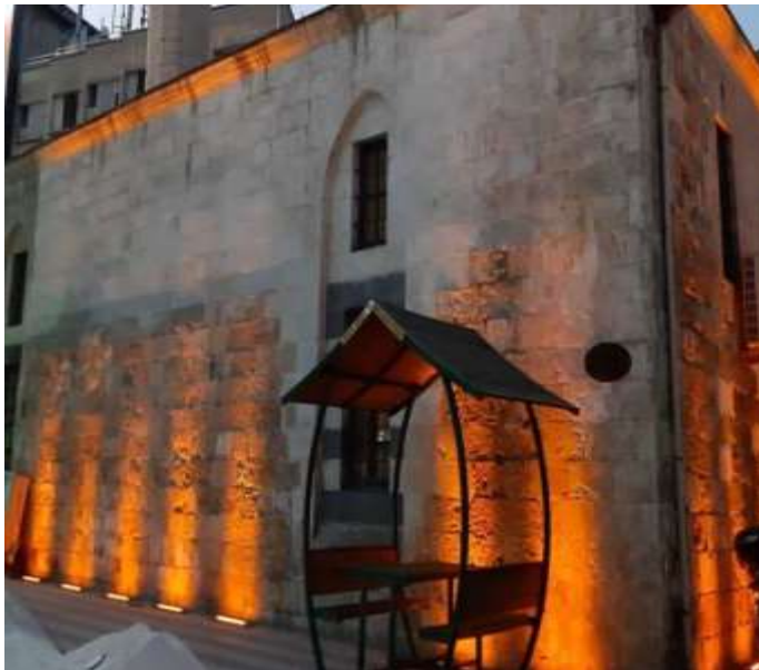
Resim-3 Karagöz Camii Güney Cephe Görünüşü
